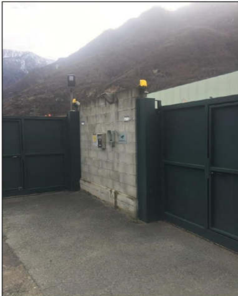
Dettagli cancello di ingresso
