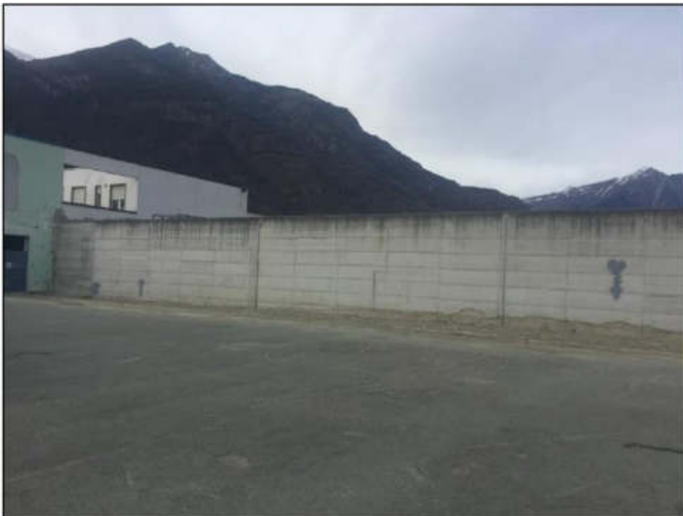
Muro di contenimento in cemento armato, vista lato interno confine settentrionale AGN Energia Autogasnord ex Mongas
