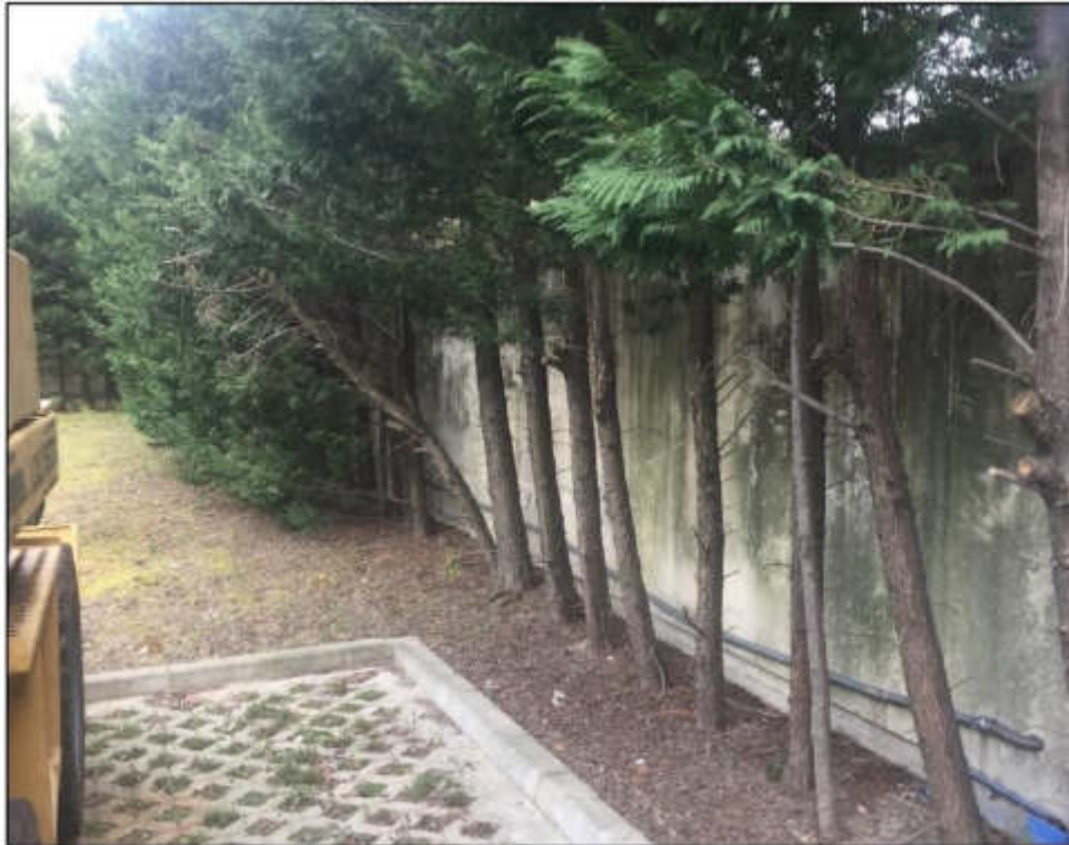
Muro di contenimento in cemento armato, vista lato interno Confine meridionale Cave Srl
