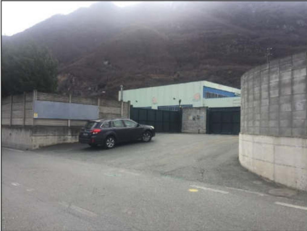
Particolare del cancello di ingresso e delle murature perimetrali Confine orientale
