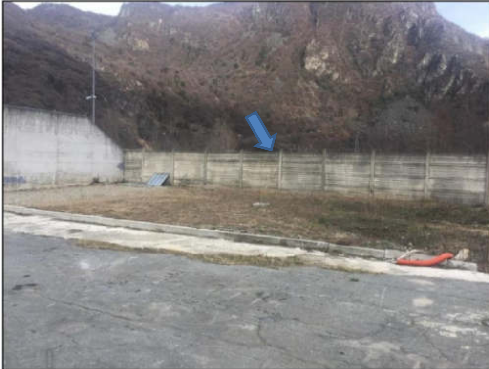
Recinzione continua in cls, vista lato interno Confine orientale
