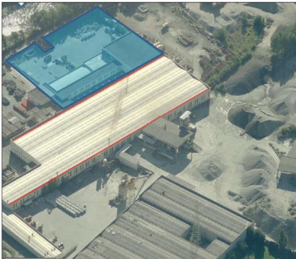
Figura 5 – Particolare dall'alto Le pertinenze di colore blu-azzurro costituiscono l'impianto Germanplast
